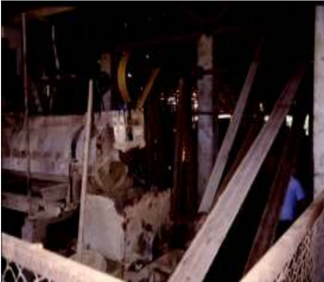
Die Ziegelei mit Transmissionsantrieb ist immer noch in Betrieb und stellt Dachziegel her.
